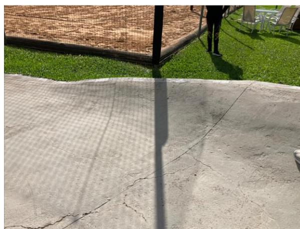
Trincas (alívio de tensão) próximas a Juntas Serradas, o que leva ao entendimento de que a profundidade do corte (junta) não fora o suficiente. Por norma, a profundidade deve ser de no mínimo  $1/3$  da espessura da placa (piso), ou seja, 3,3cm.
