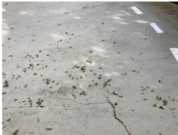
Inúmeros pontos de alívio de tensão (trincas / rachaduras) por conta do sub-dimensionamento estrutural do pavimento para solicitações de retração plástica e eventuais acomodações da sub-base (solo).
