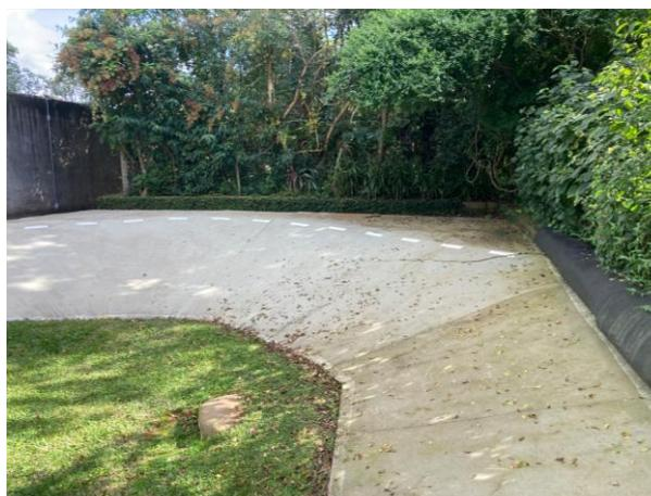
Ausência de acabamento adequado do pavimento, gerando rugosidade e opacidade acima do ideal, combinado com a falta de tratamento de superfície com endurecedores e seladores, evitando a percolação de umidade e a proliferação de micro-organismos (limo).
