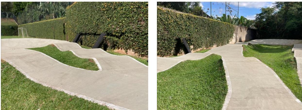
A pista consiste em uma camada de concreto simples de baixa espessura, sobre base sinuosa;
