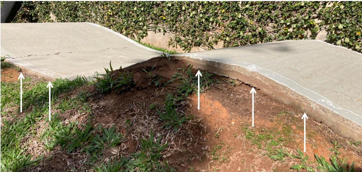
Espessura variável do pavimento, com pontos menores de 10cm. Esta variação de espessura promove comportamentos diferenciados entre os trechos com mais e menos massa de concreto, o que acarreta no surgimento de trincas e rachaduras.
