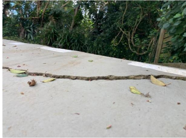
Pontos de recalque diferencial por ação da acomodação da sub-base (solo) e ausência de barras de transferência no centro da seção do piso.
